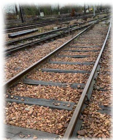
Pour rappel, l'IN1588 est le référentiel qui traite des mesures à prendre contre l'oxydation du rail et du bon fonctionnement des circuits de voies. Ceux-ci assurent la sécurité des circulations mais également le bon fonctionnement de certains passages à niveau. Des directives sont à appliquer lorsqu'il n'y a aucune circulation au-delà de 72h soit 3 jours.
